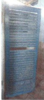
Foto 9: Cambio de puerta de madera por puerta de metal en baño de hombres.
