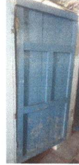
Foto 10: Cambio de puerta de madera por puerta de metal en baño de mujeres.
