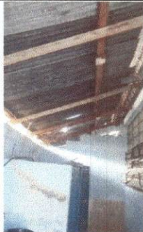
Foto 11: Cambio de laminas en baños.
